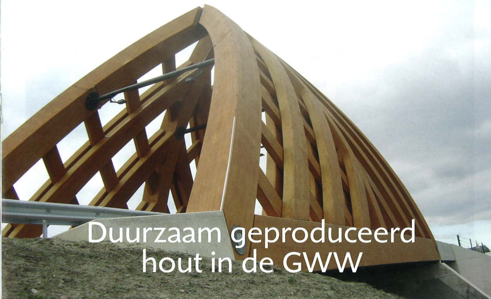
Figuur 1: Verkeersbrug voor de zwaarste verkeersklasse van gemodificeerd hout (Accoya) over de A7 bij Sneek (foto: SHR Hout Research)
