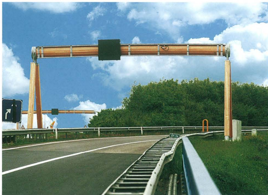
Figuur 2: De drie houten wegporthalen bij knooppunt Zonzeel nabij Breda (A57/A16) functioneren al tien jaar optimaal en onderhoudsvrij (foto: SHR Hout Research)
